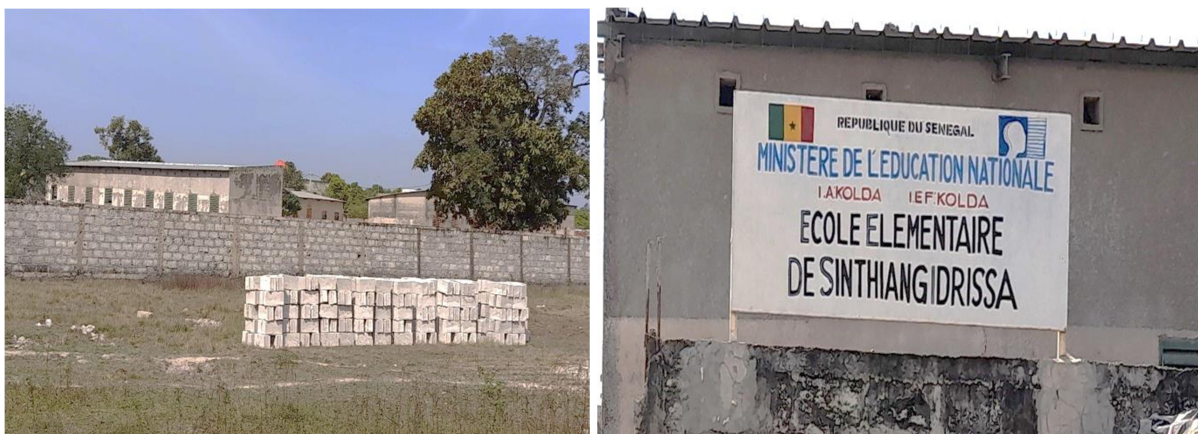
Photo 11: Installation d'une école primaire dans une zone à vocation agricole quartier Sinthian Idrissa
