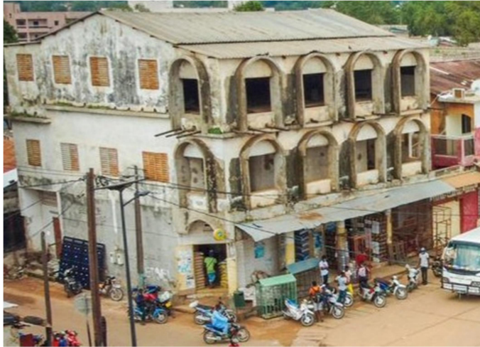
Photo 4: Edifice colonial dans le quartier d'Escale
