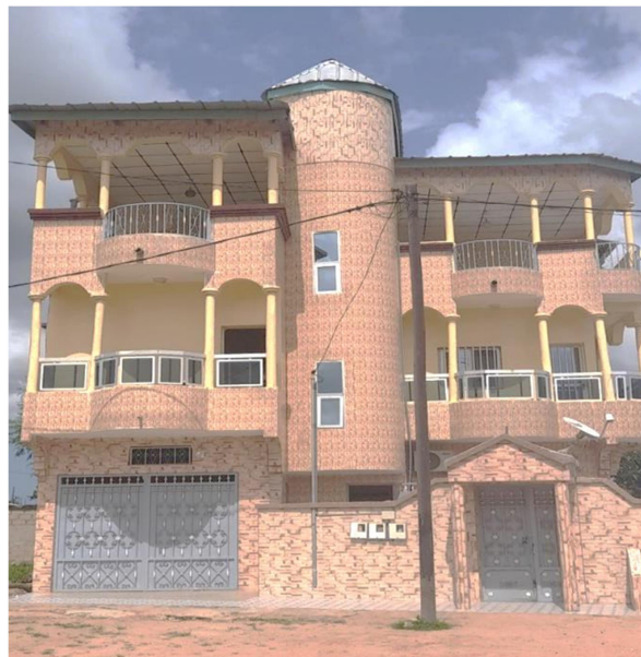
Photo 6: Maison moderne(R+2) à Médina Chérif
