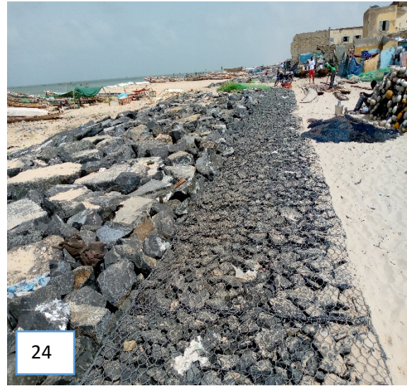
Planche de photos n° 23 et 24 : Digue de protection d'enrochement latéral Cliché : M. Faye 28/08/2022.
