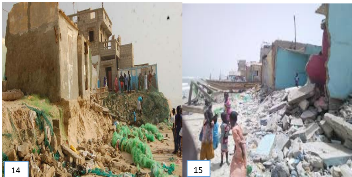
Planche de photos n° 14 et 15 : Effondrement des maisons sous l'effet de la houle, source : (profil environnemental de Saint Louis)
