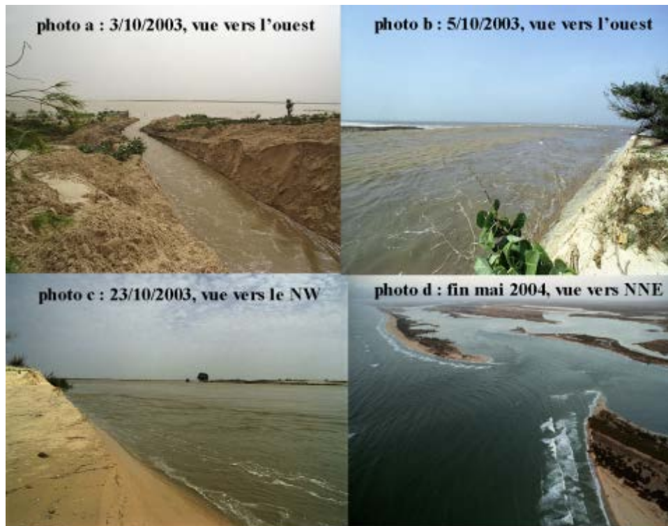
photo a : la brèche juste après son ouverture: 4 m de large photo b : la brèche 2 jours après son ouverture : 80 m de large photo c : la brèche 3 semaines après son ouverture : 330 m de large photo d, la brèche 8 mois après son ouverture : 800 m de large Source : photos Ibrahima Diop, service hydrographique de la ville de Saint-Louis
