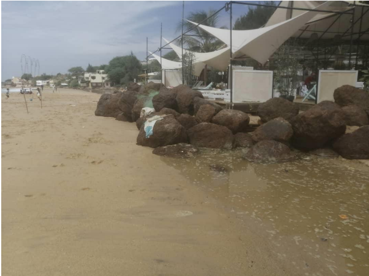
Photo 10 : Enrochement devant l'hôtel « l'Eco côtier » contre les assauts des vagues (FALL, 30/12/2021)
