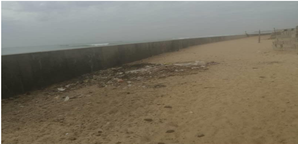
Photo 3 : Erection d'un mur par l'Etat pour la protection des quartiers traditionnels de Ndayane (FALL, 30/12/2021)
