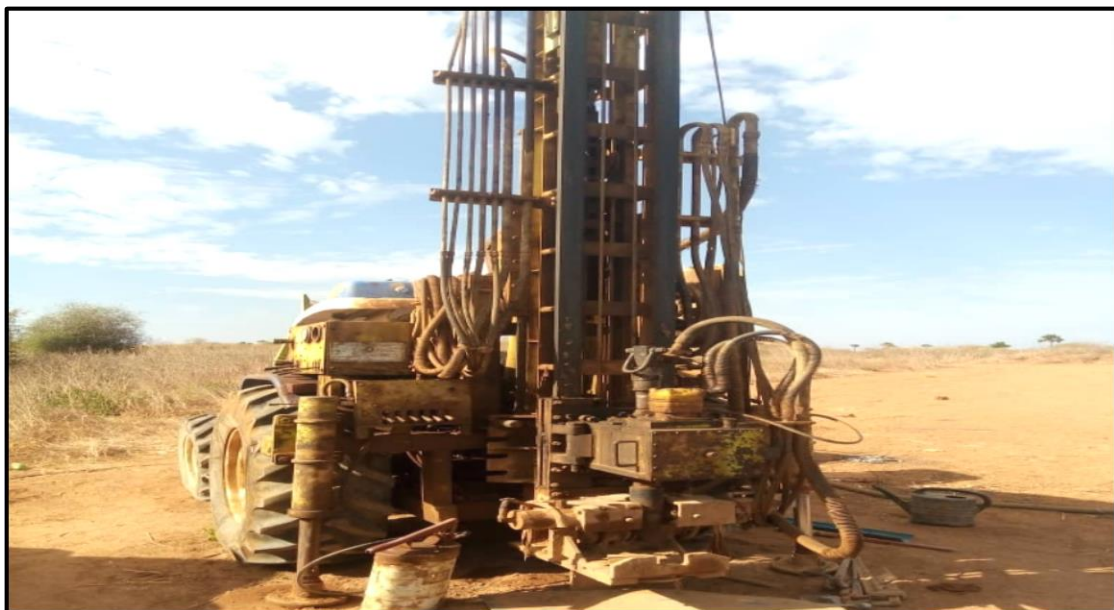
Photo 4 : Machine de sondage pour l'exploration de phosphate (Source : SEPHOS 2018)
