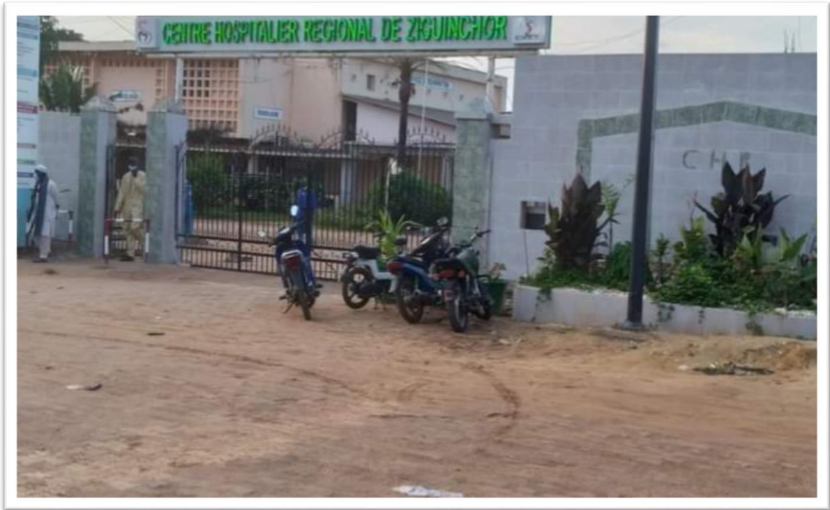
Figure 15 : Le centre hospitalier régional de Ziguinchor
