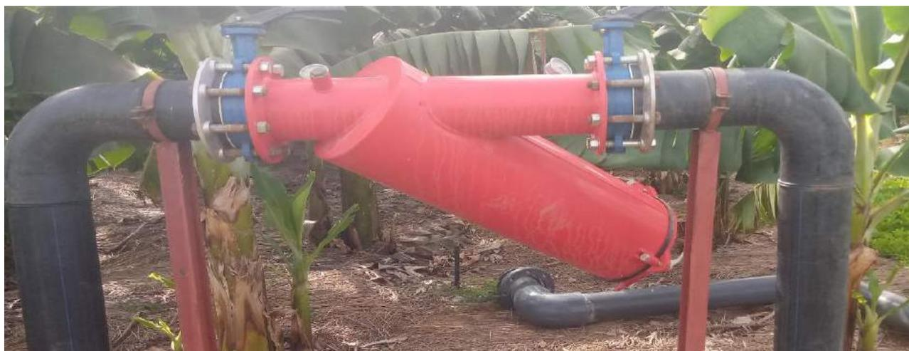
*Photo 10.3. En rouge, un filtre au niveau des réseaux d'irrigation en système aspersion (Diallo, mars 2021).*
