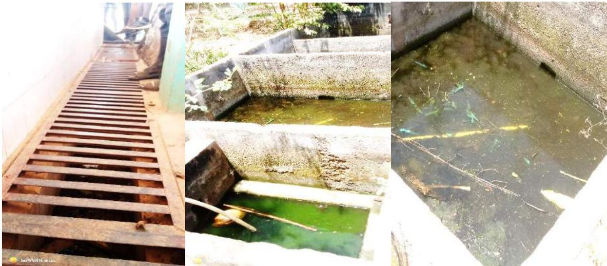
*Photo 12 : canal d'évacuation des eaux usées (à gauche) et stagnation des eaux usées dans les mini-bassins (Diallo, mars 2021)*
