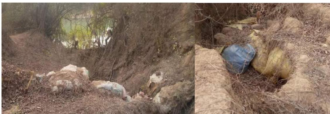
**Photo 5: Gabion placés sur une ligne de crue à l'environ de Nguène (Diallo, avril 2021)**
