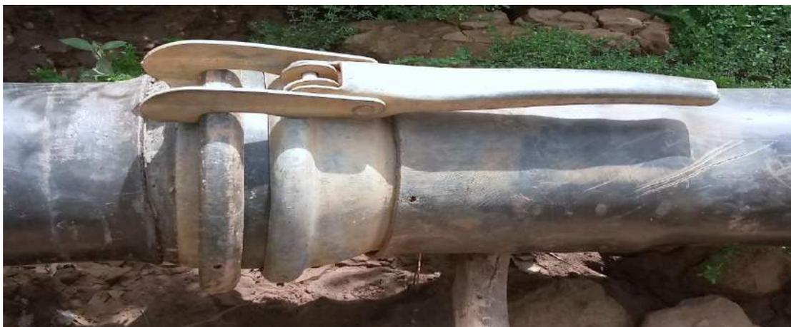
*Photo 4 : nœud de branchement des tuyaux d'extension (Diallo, mars 2021)*
