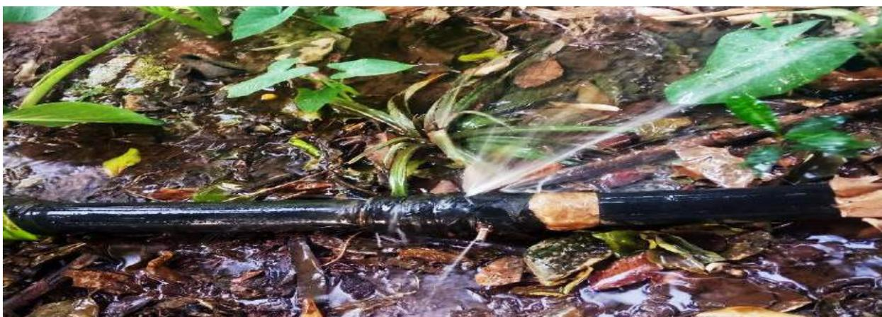
*Photo 11.2. Fuite d'eau au niveau des tuyaux secondaires*
