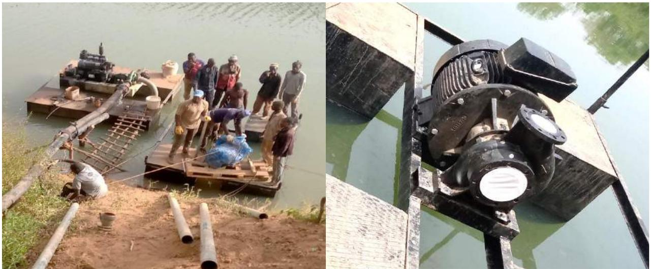
*Photos 9.3. Installation du moteur solaire au GIE Gorgorlou et aperçu du moteur solaire à Sankagne 2 (Diallo, mars 2021)*
