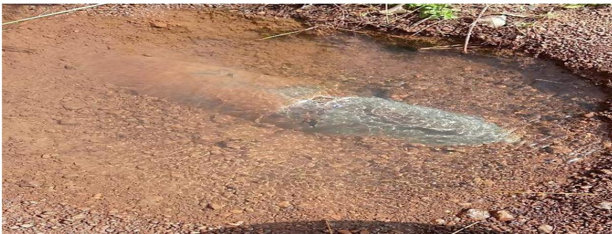
*Photo 11.1. Fuite d'eau au niveau des tuyaux principaux*
