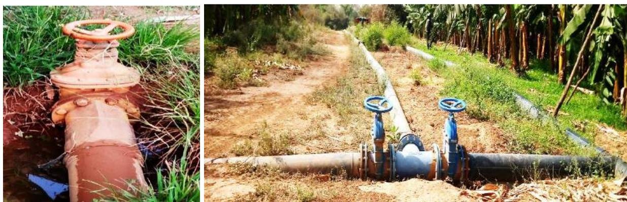
*Photo 13 : Les vannes installées aux niveaux des tuyaux pour assurer les tours d'eau par bande (Diallo, mars 2021)*
