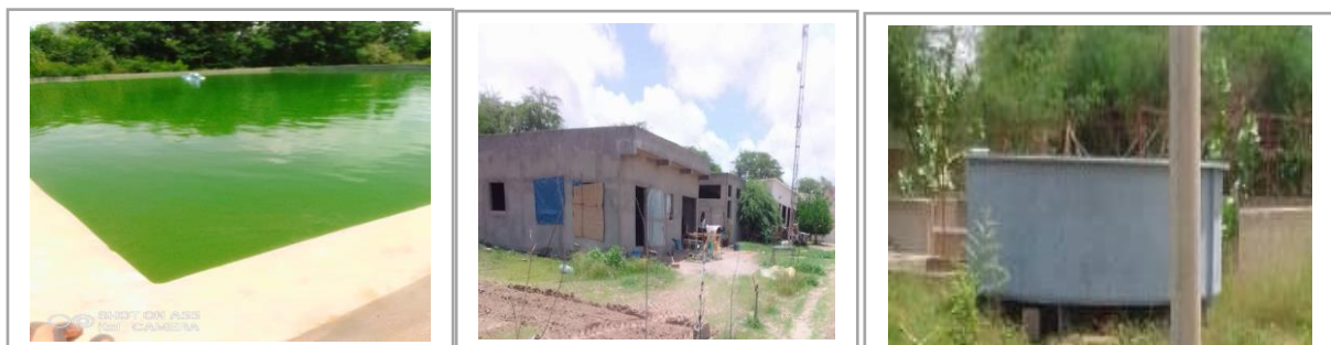
Bassin en béton (crédit : M. Niang)
