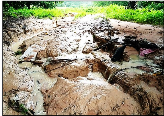
Photo 1 : Digue de désenclavement dégradée par la marée à Effoc Photo 2 : Route départementale 14.2.00 dégradée par les eaux de ruissellement à Effoc
