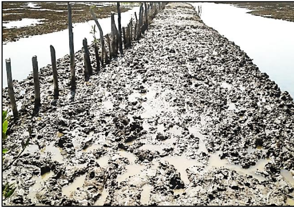
Photo 1 : Digue de désenclavement dégradée par la marée à Effoc Photo 2 : Route départementale 14.2.00 dégradée par les eaux de ruissellement à Effoc
