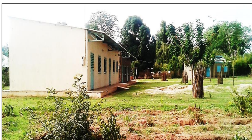
Photo 24 : Absence de clôture au CEM d'Effoc (Source : Coly, juillet 2020)
