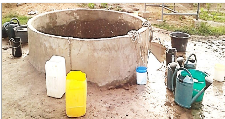
Photo 33 : Seul puits assurant l'approvisionnement en eau dans le bloc maraîcher d'Effoc (Source : Coly, février 2020)
