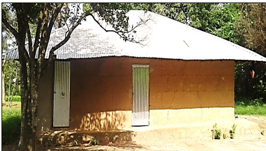
Photo 3 : Maison en banco à Effoc (Source : Coly, juillet 2020)
