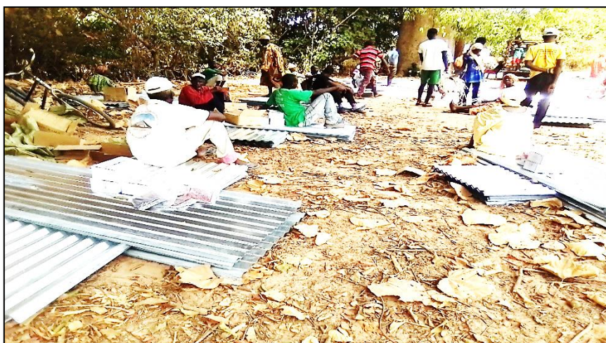
Photo 5 : Distribution de tôles par le CICR à Effoc pour encourager le retour des populations déplacées à cause du conflit en Casamance (Source : Coly, avril 2020)
