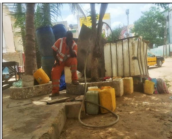
Photo 14 : Unité de pompage située à l'unité 16 de la CPA (DIOP M, Août 2021)
