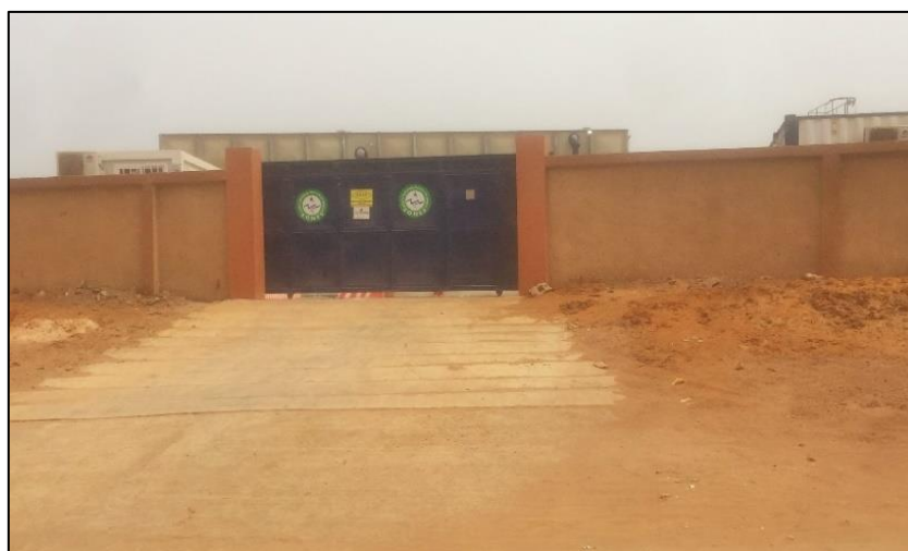
Photo 19 : Devanture de l'unité de déferrisation des forages du « LYMODAK » (DIOP M, Août 2021)
