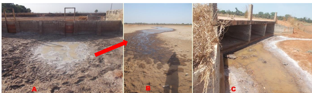
Photo 9 : Confinement des eaux du marigot de Djibanar : tarissement de l'eau et cristallisation du sel en amont de l'ouvrage de régulation du niveau d'eau de la digue anti sel (photo A) près de la RN6 B état de l'eau à environ 50m en amont de la digue et et C cristallisation du sel au niveau de la digue de vallée de Birkama et Djibanar, (Cliché Mansaly Mai 2018)
