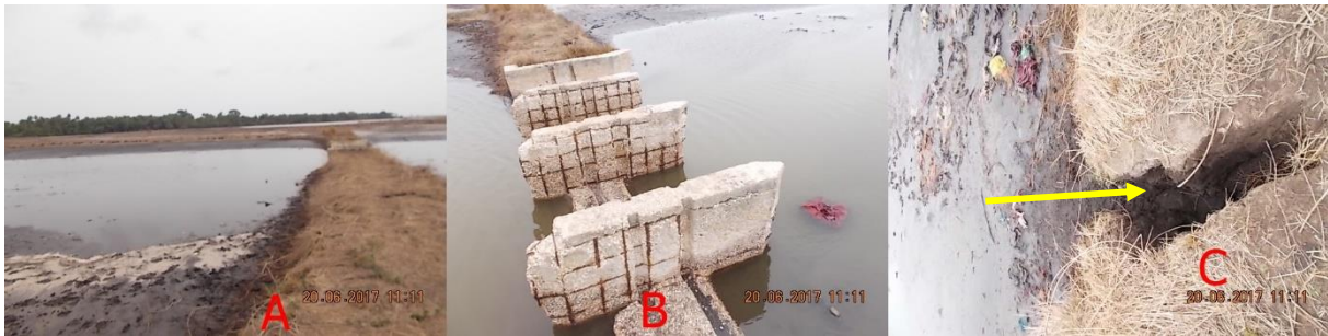
Photo 17: Digue anti sel traditionnelle et son ouvrage en béton de Pontou (en A et B) et attaque de la même digue par les rongeurs en C (vue de haut) (clichés Mansalu, 2017)
