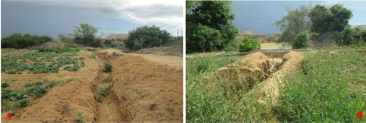
**Photographie 10** : Passerelle manuellement creusée par les maraichers (A) pour évacuer l'eau des parcelles inondées vers un point d'eau (B) (Source : Seck, 2018)
