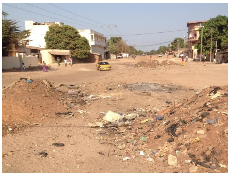
Photo 8 : Voie urbaine classée 204, au quartier Nema .
