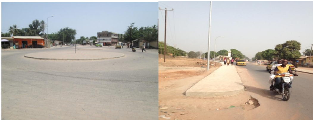
Photo 5 : Rond- point Banéto au quartier kandé . Photo 6 : Nouveaux poteaux d'éclairage public et trottoirs sur la route des Sapeurs-Pompiers.
