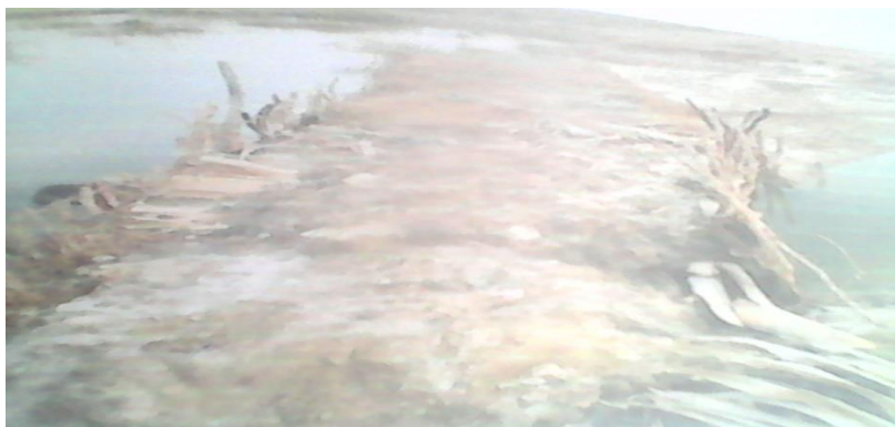
Photographie 4: Digue de protection contre la remontée des eaux salées Pontadoss (Cliché : GOMIS C. 2016)
