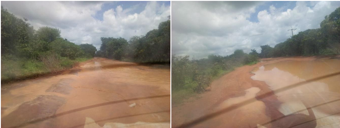
Photo 36 et 37: Route internationale Sénégal-Bissau guinée en saison des pluies (Source : Cliché S. DRAME Aout 2018 )
