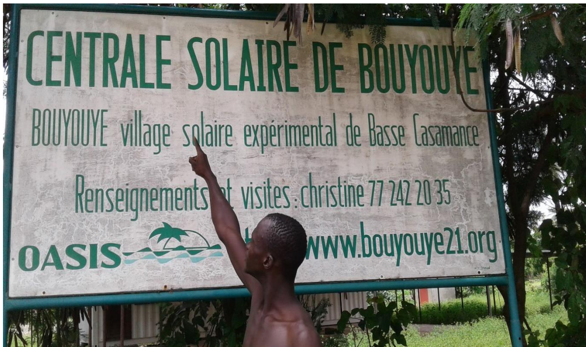
Photo 8 8 : Centrale solaire du village de Bouyouye (Date : 29/02/17, Cliché : DIEME, 2017)
