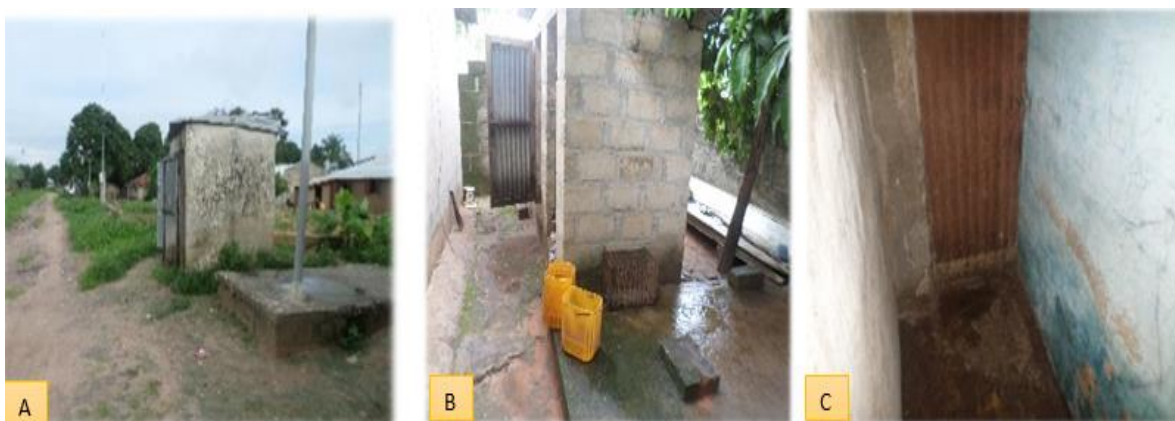
Photo 4: Dans la rue (A) En dehors du bâtiment (B) Dans le bâtiment
