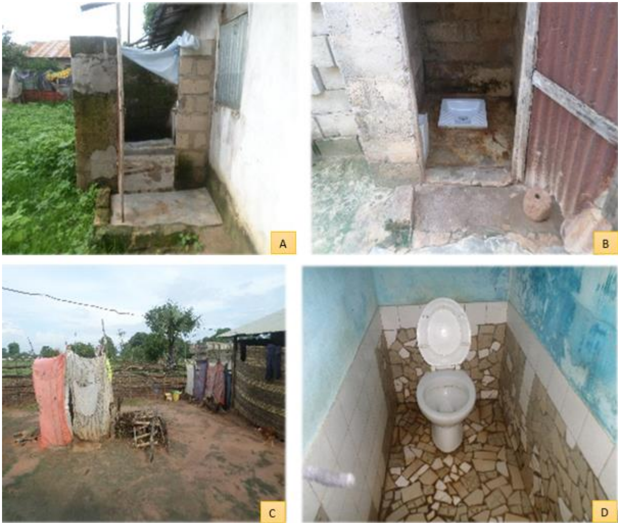
Photo 3: Latrine simple (A) Latrine améliorée (B) Trou traditionnel (C) Fosse septique (D)
