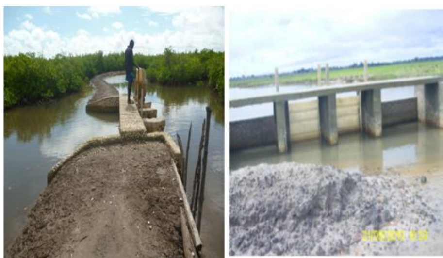
Photo 15: Digues construites par l'AECI et le GRDR à Cagnao et à Kafone (Cliché: Edouard Diatta, 2013)
