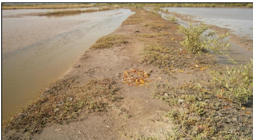
Photo 21: Digue anti-sel réalisée dans le village d'Adéane. (Source : Badiane, 2015 )
