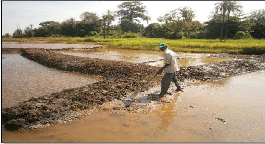
Photo 19: Construction de Digue dans les rizières d'Adéane. (Source : Badiane 2015)
