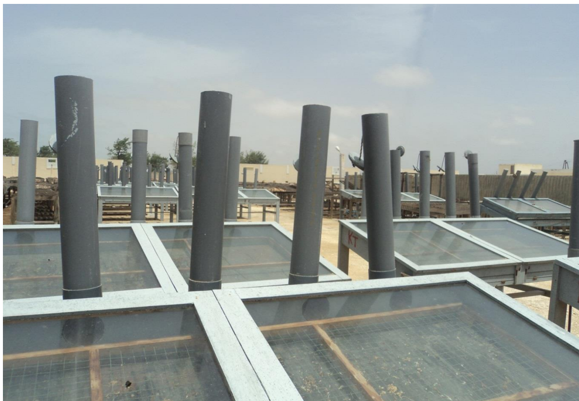
Photo 5 : Les fours de séchage
