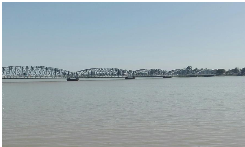
Photo 5: Le Pont Faidherbe
