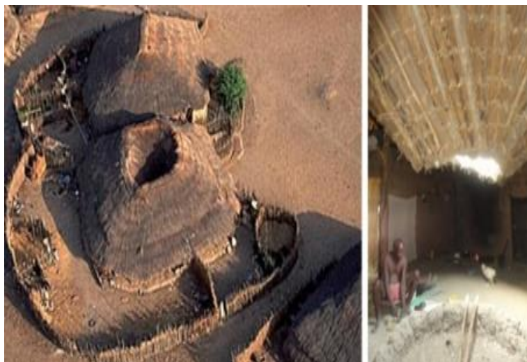
Photo 3 : Case à impluvium : vue d'en haut et de l'intérieur 25
