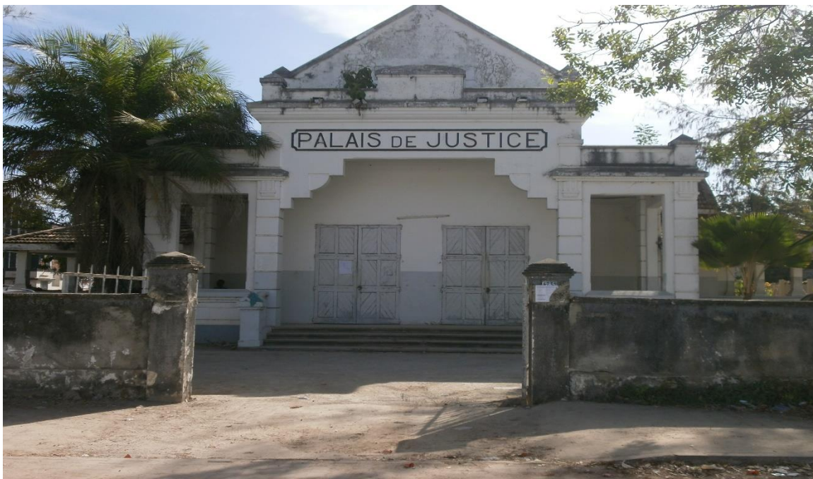
Bâtiment abritant le « Tribunal régional de Ziguinchor ». Il est situé au quartier Escale et fait face au Commissariat Central.
