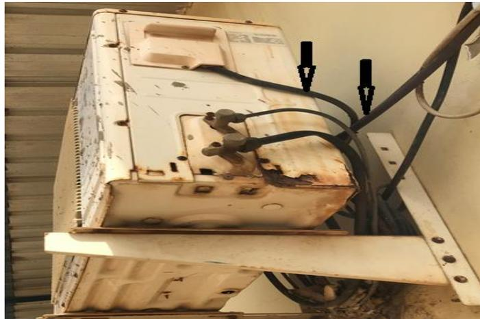
Figure 27: Absence d'isolation des tuyaux assurant l'échange de chaleur
