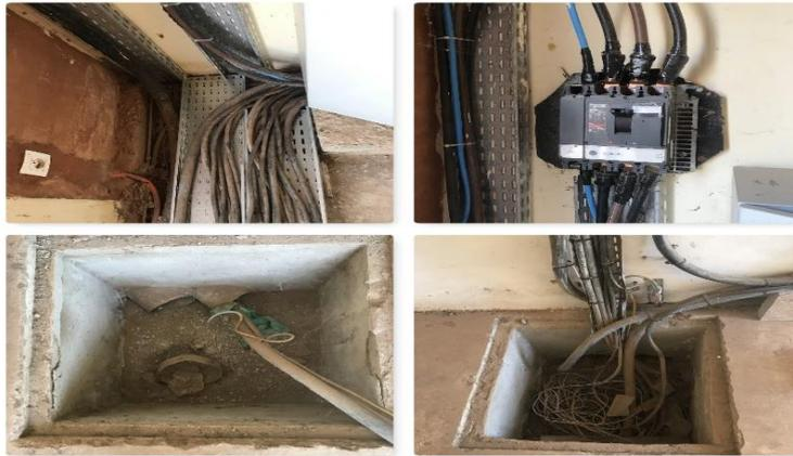
Figure 12: Quelques installations non conformes aux normes NFC 15-100
