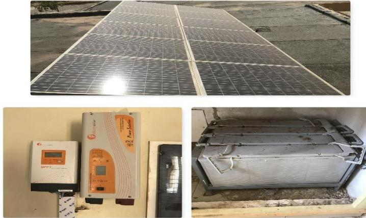
*Figure 14: Système photovoltaïque de l'hébergement 1*
