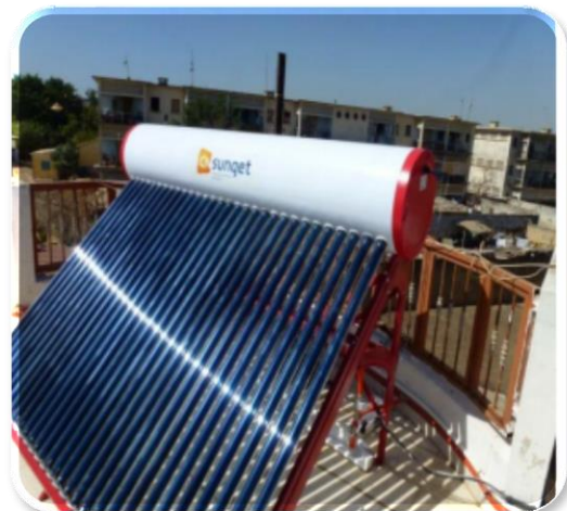
Figure 1.3-3 : Installation d'un chauffe-eau solaire
