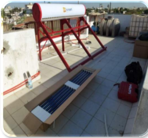
Figure 1.3-3 : Installation d'un chauffe-eau solaire
