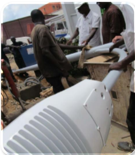
Figure 1.3-2: Installation d'un lampadaire solaire
