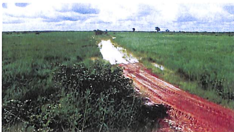
DTG_213 bouché – piste inondée
