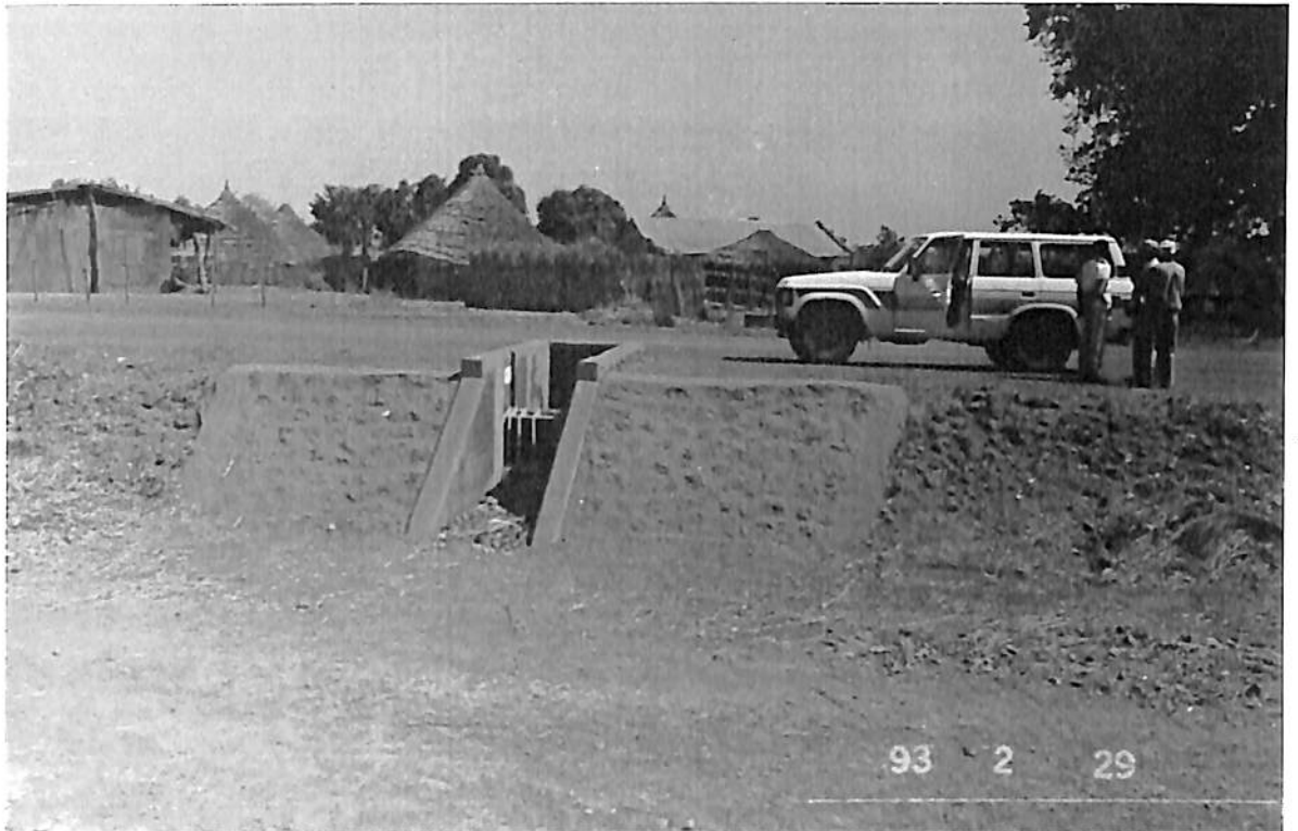
PREMIERE PRISE D'EAU (SITUEE SUR LA BERGE RIVE DROITE)
