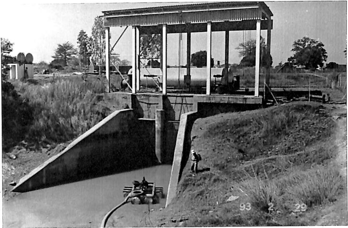
STATION DE POMPAGE PROVISOIRE : VUE DE COTE DU CHANAL D'AMENEE LES (DEUX) POMPES DIESEL SONT EN REPARATION EN FRANCE ;
