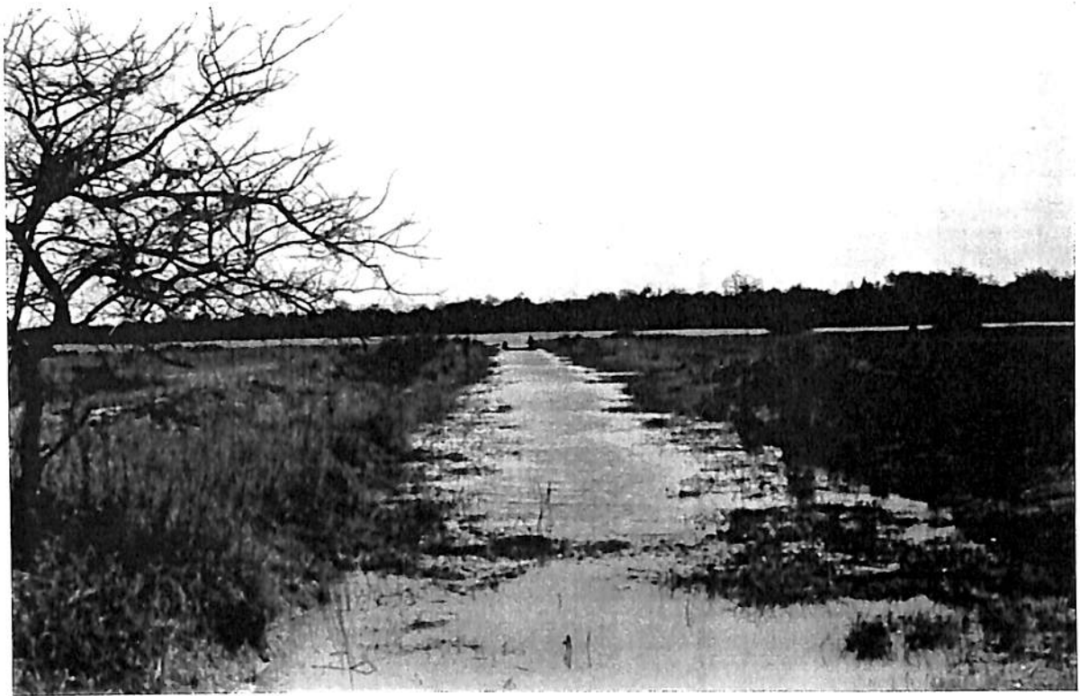
VUE VERS L'AMONT. A L'AMORCE DU CHENAL D'AMENEE ; PRISE DE VUE DANS L'AXE LONGITUDINAL DU CHENAL ;
