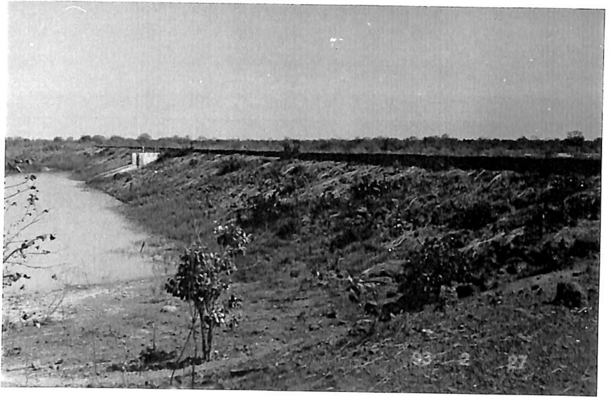
BARRAGE DU CONFLUENT VUE DE LA RIVE DROITE DE LA RETENUE COTE PAREMENT AMONT
