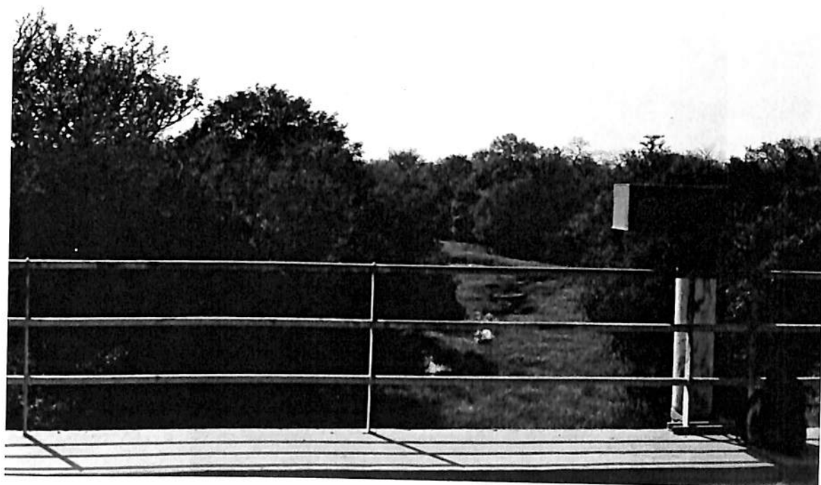
VUE VERS L'AVAL DU PONT ROUTIER DE WASSADOU ; LE LIMNIGRAPHE EST RATTACHE AU PONT ; L'APPAREIL EST HORS SERVICE DEPUIS 1992.
