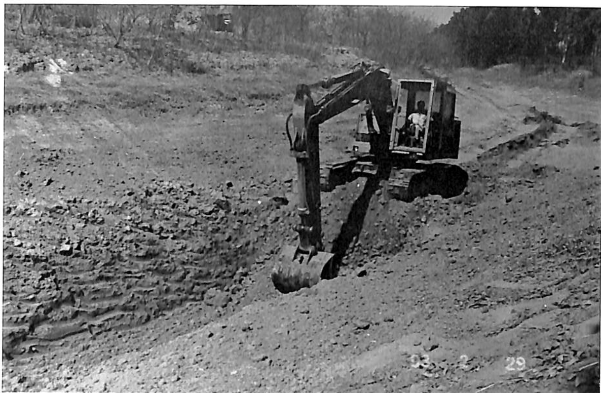
CURAGE DU CHENAL D'AMENEE EN COURS : APPROFONDISSEMENT ET ELARGISSEMENT A LA FOIS ;
