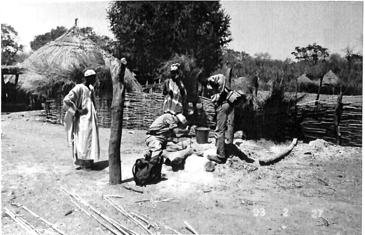
PUITS VILLAGEOIS A COTE DE SARE DIAYE NIVEAU D'EAU AU PUIS : 14 METRES EN DESSOUS DU TERRAIN NATUREL
