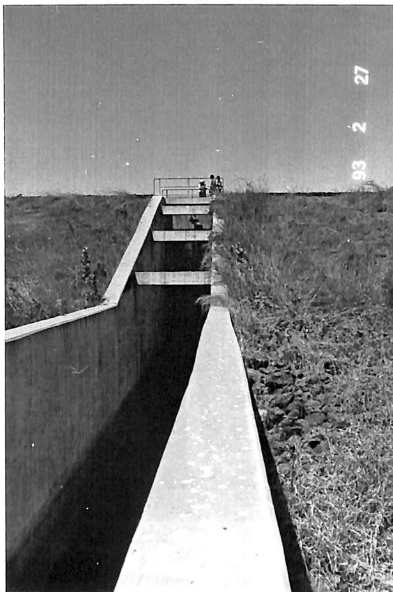
BARRAGE DU CONFLUENT (CONSTRUIT EN 1983) VUE DU PAREMENT AVAL, AVEC LES MURS BAJOYERS DE L'OUVRAGE DE VIDANGE DE FOND ; LE RACCORDEMENT TERRASSEMENT ↔ BETON A ETE BIEN FAIT ;
