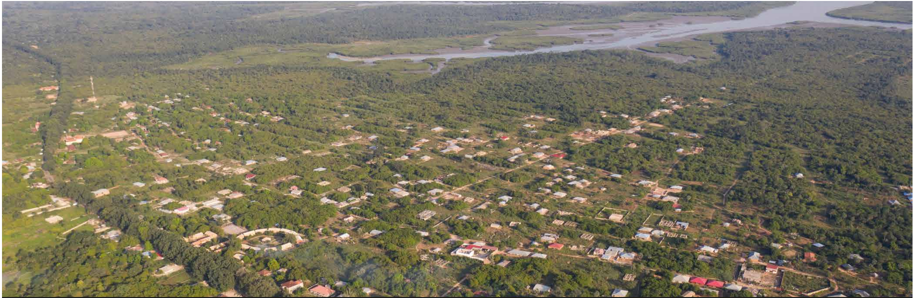
Photo 26 - Vue aérienne des nouveaux quartiers lotis
