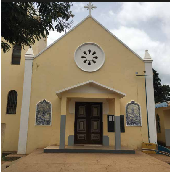
Photo 21 - Des édifices religieux qui structurent le paysage urbain : Eglise catholique
