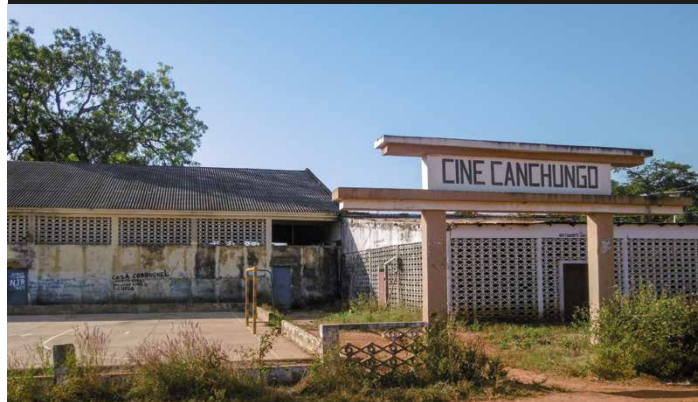
Photos 12-13-14 - Infrastructures héritées de la période coloniale
