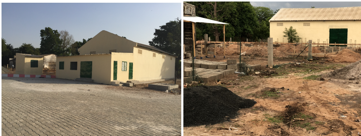
Photo 2-5 : Hangar construit par l'UEMOA (Gauche) et chantier du PAMCS (droite). Cliché : Tropica, 07/18
