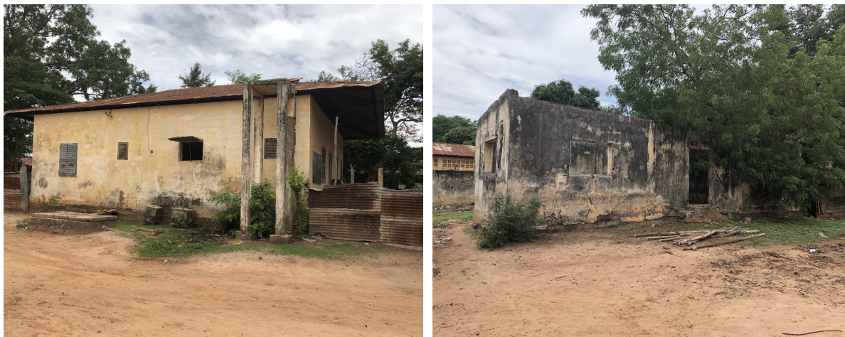
Photo 7-1 : Vues des principaux bâtiments à démolir. Cliché : Tropica, juillet 2018
