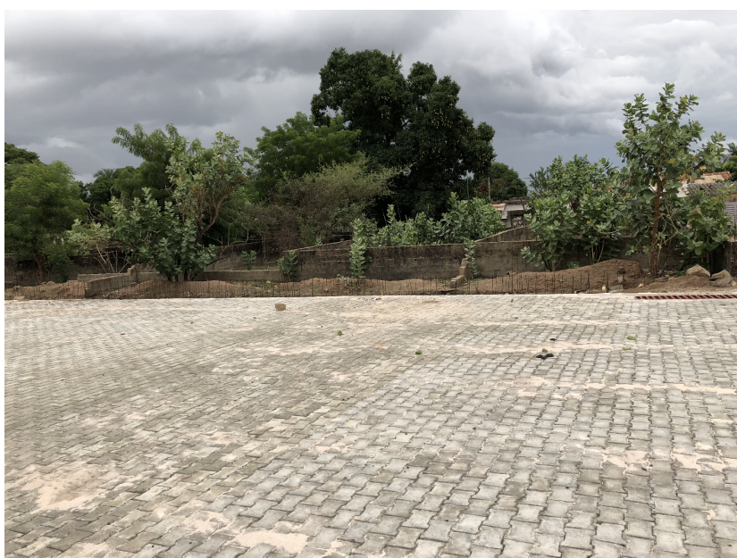
Figure 2-5 : Vue du début de construction du magasin financé par le PADERCA
