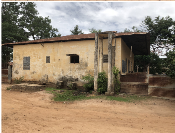
Photo 5-3 : Vue de bâtiments à démolir dans la phase 2 de la PEIB. Clichés : Tropica, juillet 2018
