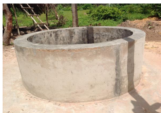
Photos 3&4 : Puits et support en béton armé à Kamoboul (Région de Ziguinchor)
