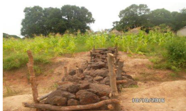
Photos 11&amp;12 : Diguettes en cadre dans les régions de Tambacounda et Kolda
