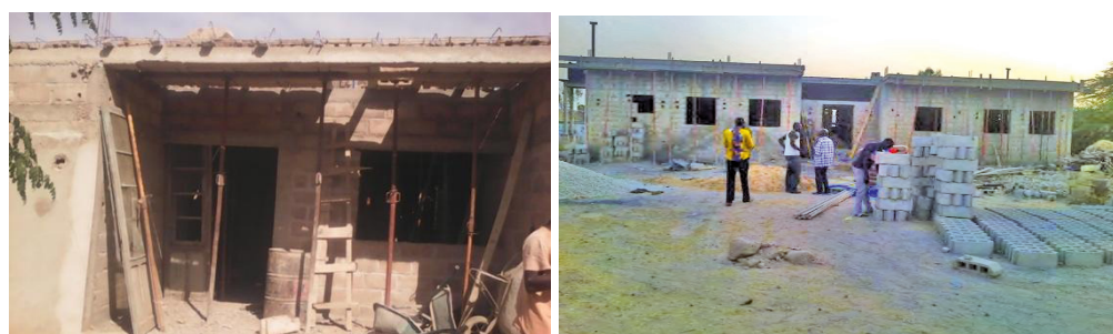
Photos 13&14 : Travaux sièges des antennes de Fatick et Matam
