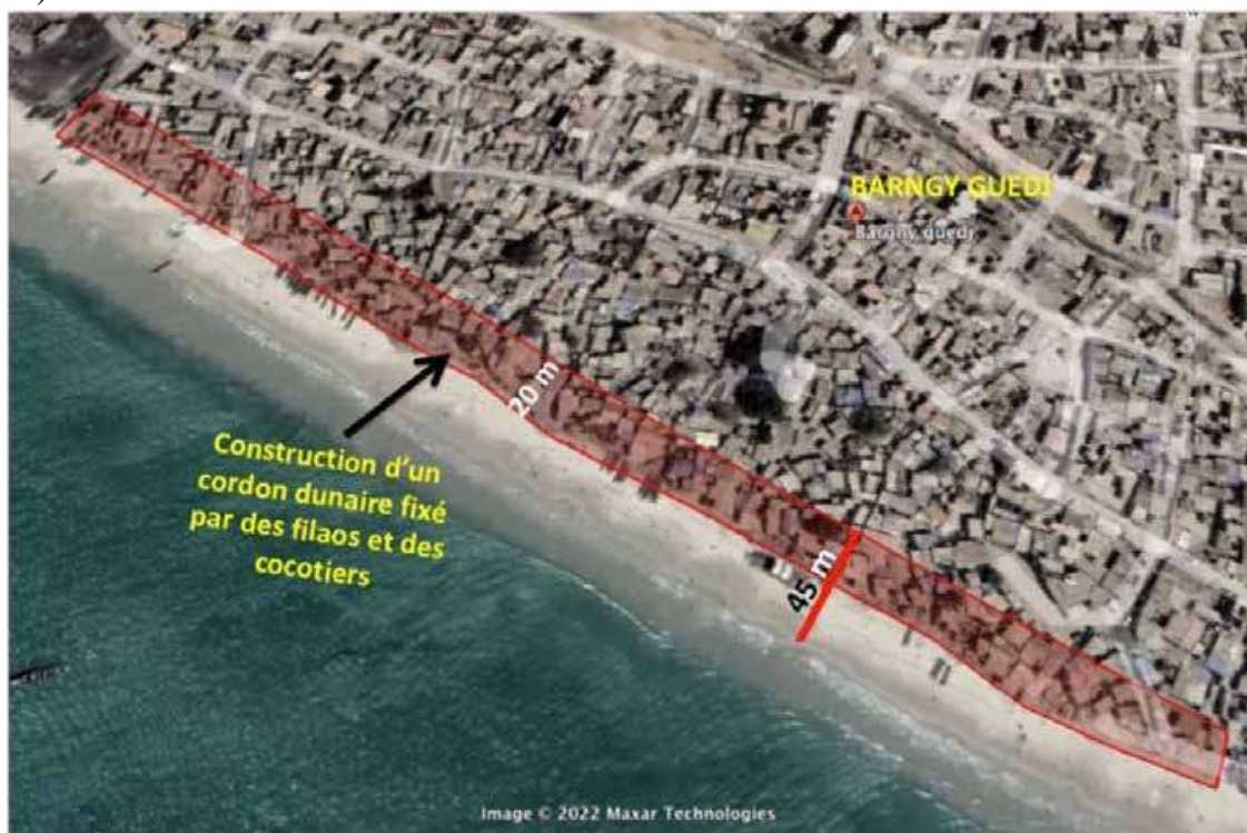
Figure 34 : repli stratégique avec la construction d'un cordon dunaire
