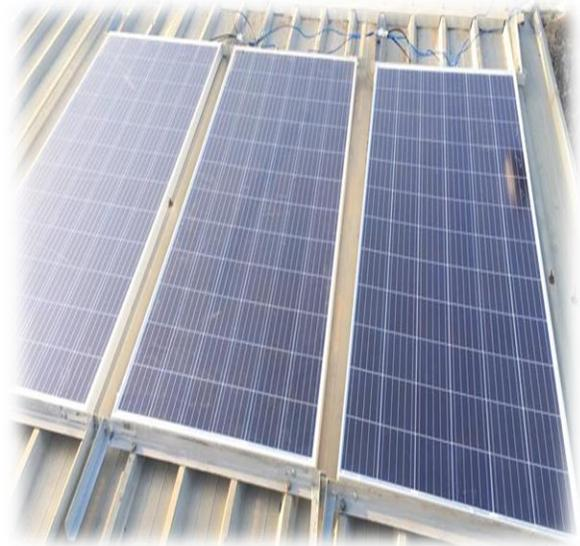
Figure 28 : Branchement des panneaux en parallèle
