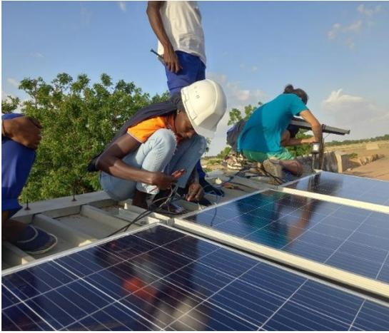
Figure 30 : Montage des panneaux du dispensaire
