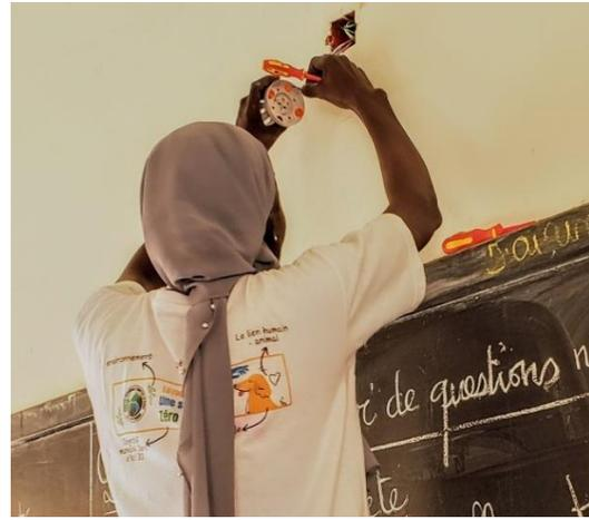
Figure 31 : Câblage des lampes d'une salle
