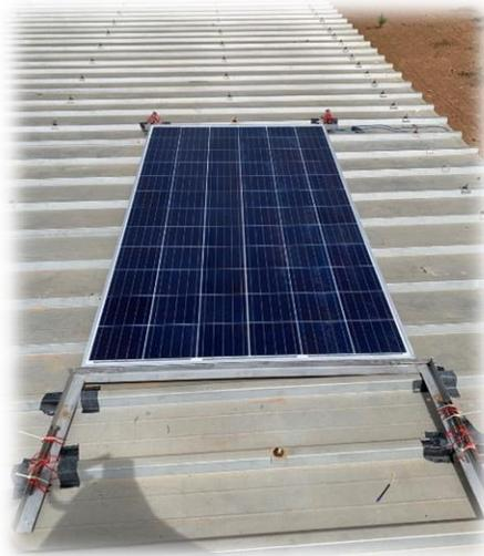
Figure 16 : Module polycristalline de 24 V/350 W ;  $V_{oc} = 45,82V$  et  $I_{sc} = 9,1A$
