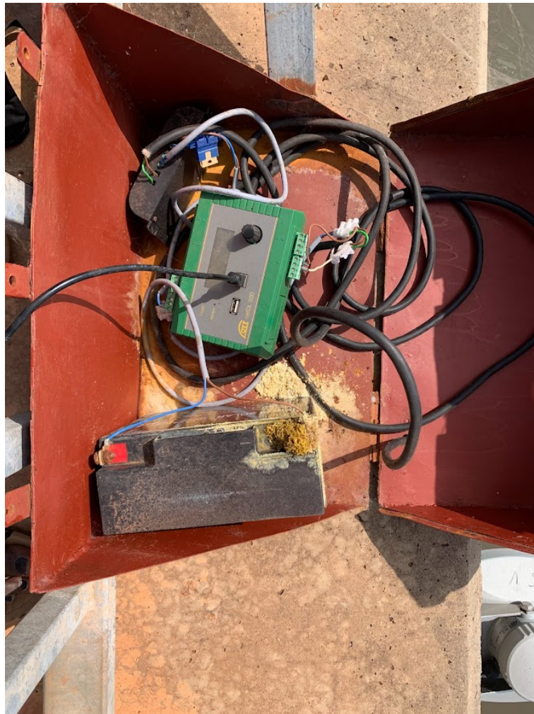
FIGURE 4.10: État des batteries après une année d'utilisation
