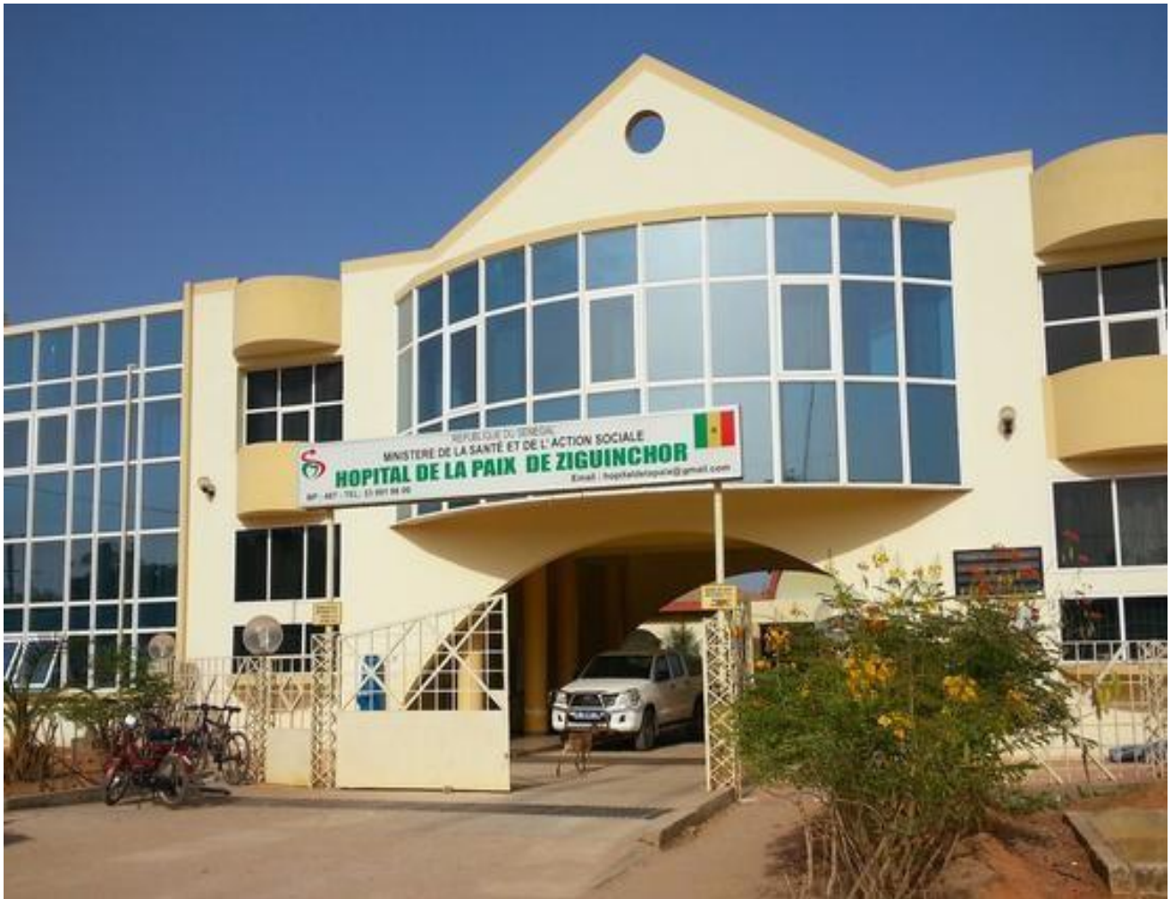
Figure 9 : Hôpital de la paix de Ziguinchor vue de face [97]
