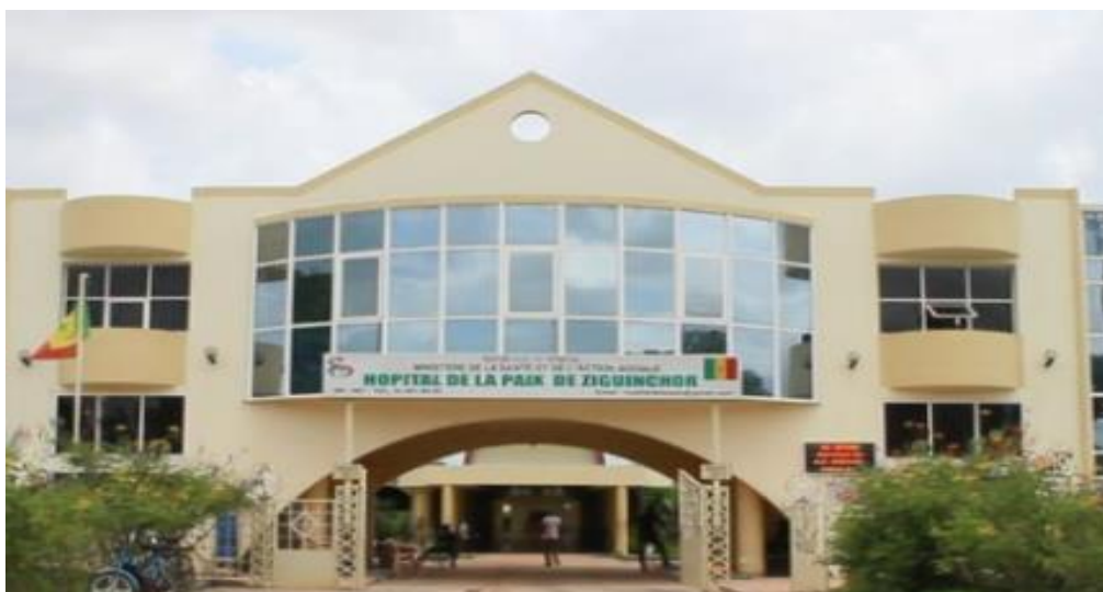
Figure 39 : hôpital de la paix de Ziguinchor
