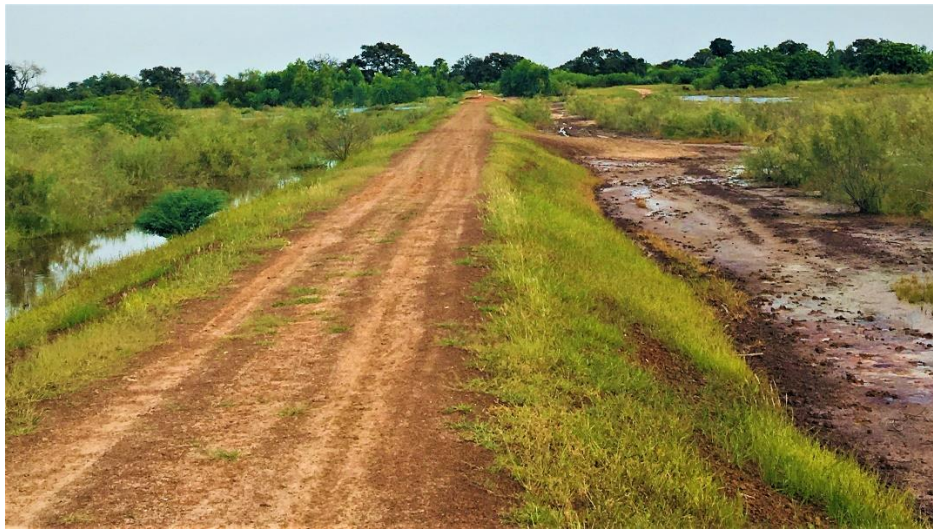
Photo 10 : Digue anti sel au niveau de la vallée du sine dans la zone de Sanghaie (Source : cliché SENE, septembre 2022)
