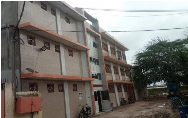
Figure 1.1 : Image du bâtiment de la SCPL
