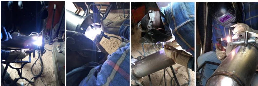
Figure 3. 12 : Photos durant les travaux de soudure
