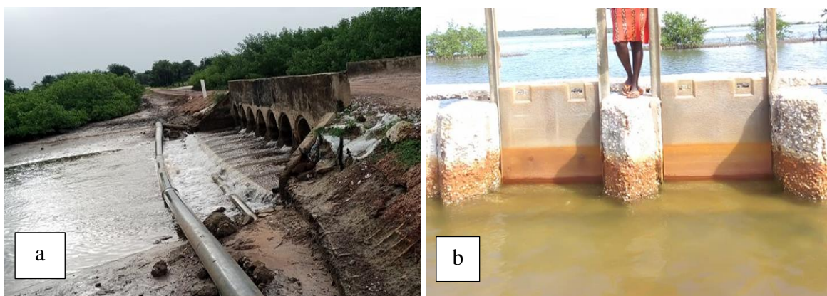
Photo 5: (a) Digue équipée de vannes à Loudia Diola ; (b) Mini barrage à Effoc
