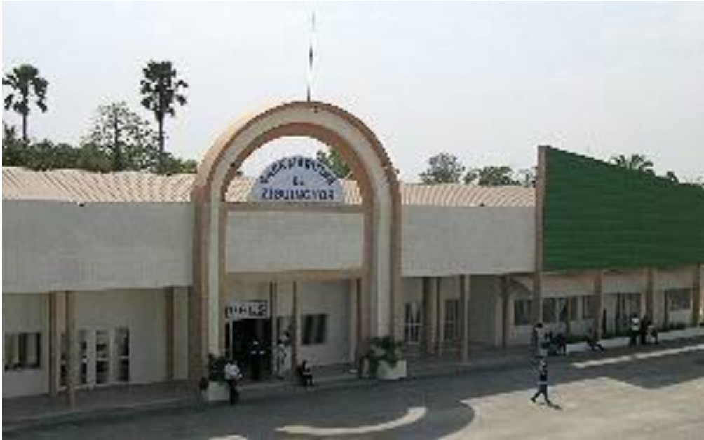
FIGURE N°10 : La gare maritime moderne de Ziguinchor pour accueillir la liaison maritime avec Dakar. Source :
