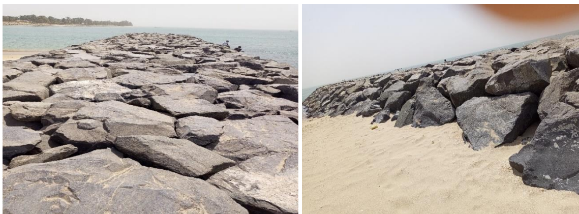
Photos 2: Ouvrages de protection sur les plages de Saly occasionnant le transfert de risques (YADE, février 2022).
