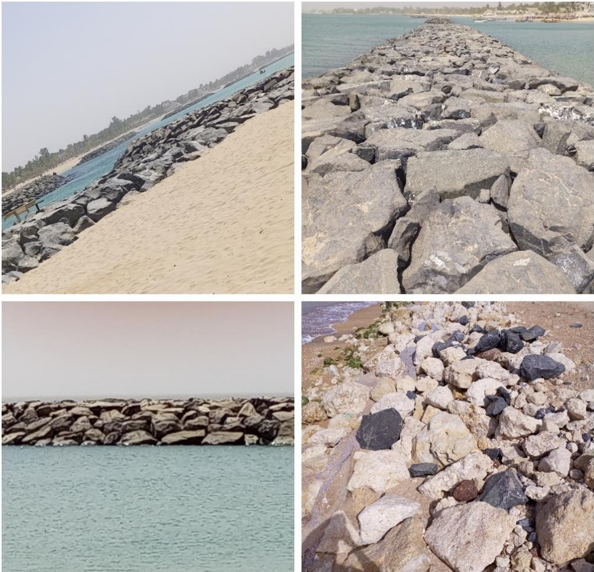
Photo 8: stratégies d’adaptation collectives (Brises Lames) à la station balnéaire de Saly (Source : Yade, Février 2022).
