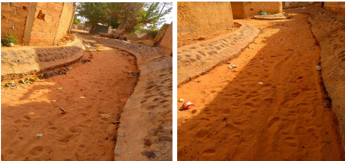
Photos 8 et 9 : Passage d'eau des inondations au niveau de Diass central (Niang S, Février 2021)
