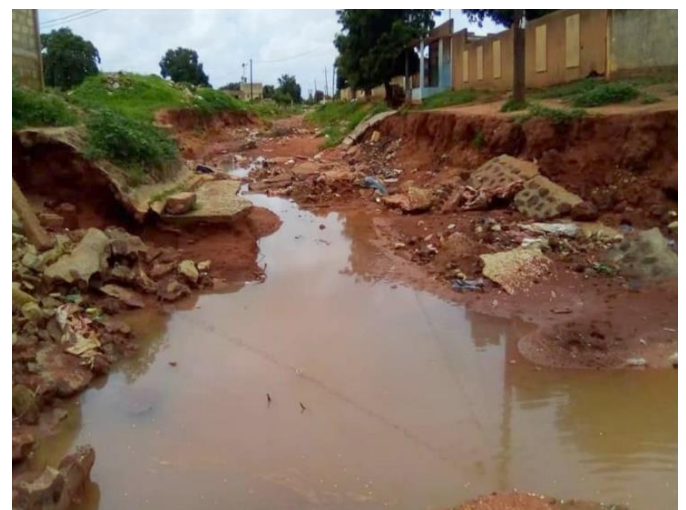
Le canal de Diass et ces dégâts
