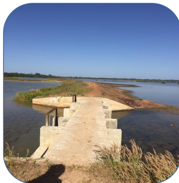
Figure 13 : Ouvrage de la vallée de Bougolor
