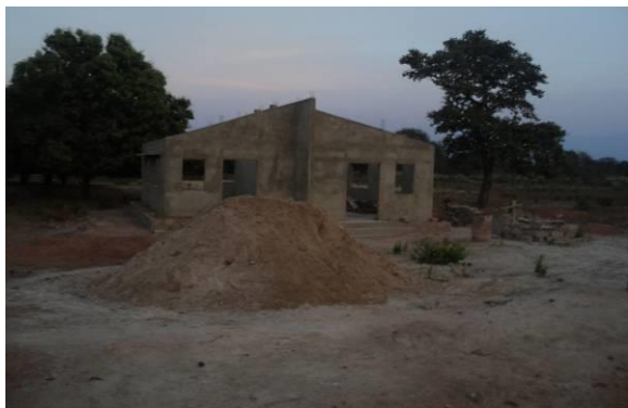
Un local de transformation de produit en construction vers les villages de DIEBA et de SINDIALONG
