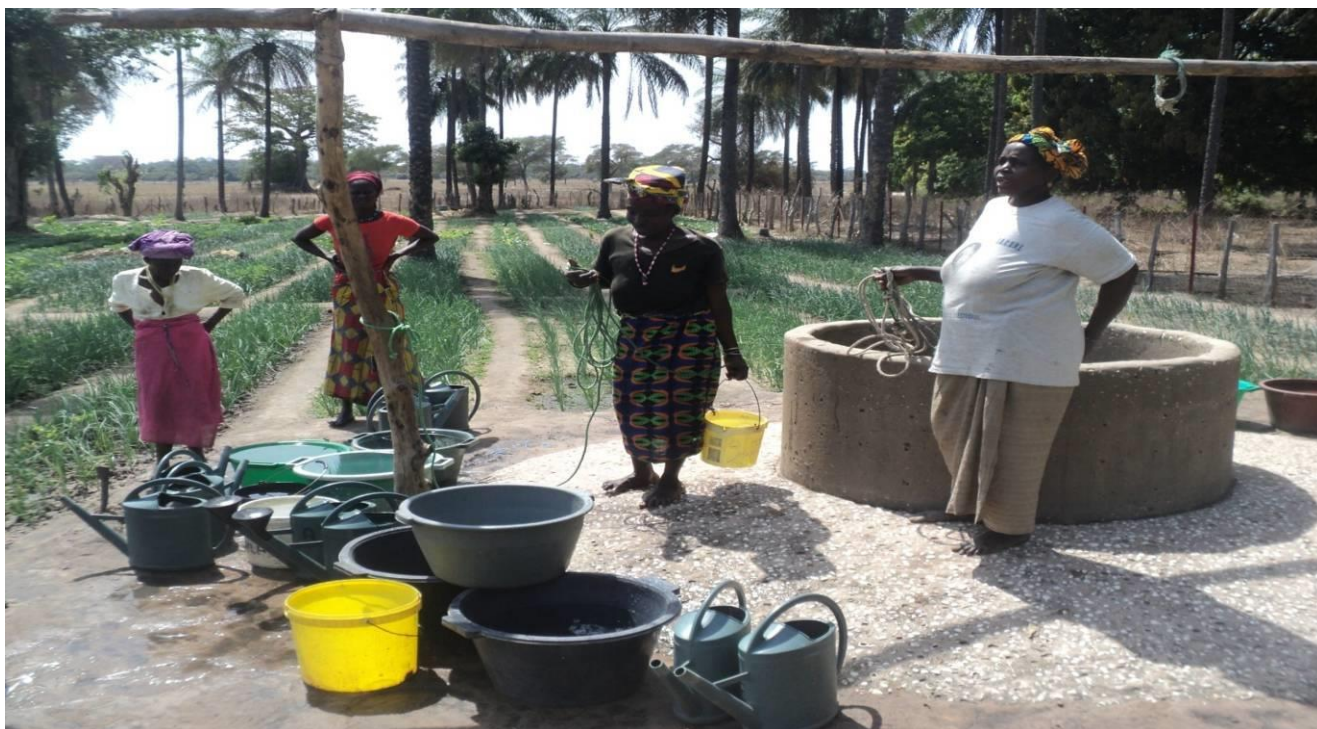
Un périmètre maraîcher dans la zone du Bouloufe et son puits en appui au système de panneau solaire souvent défaillant
