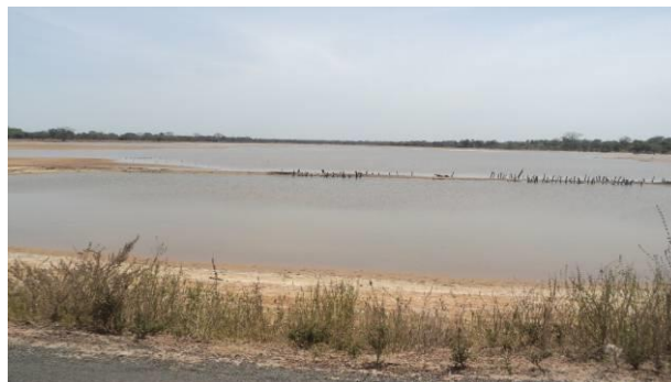
La lutte contre l'avancée de la langue salée dans la communauté rurale de Diécoune (au centre une digue de protection contre la remontée du sel)
