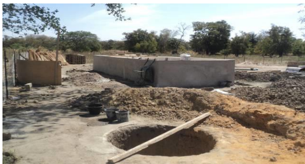
Les travaux en cours du centre de pisciculture de Pata
