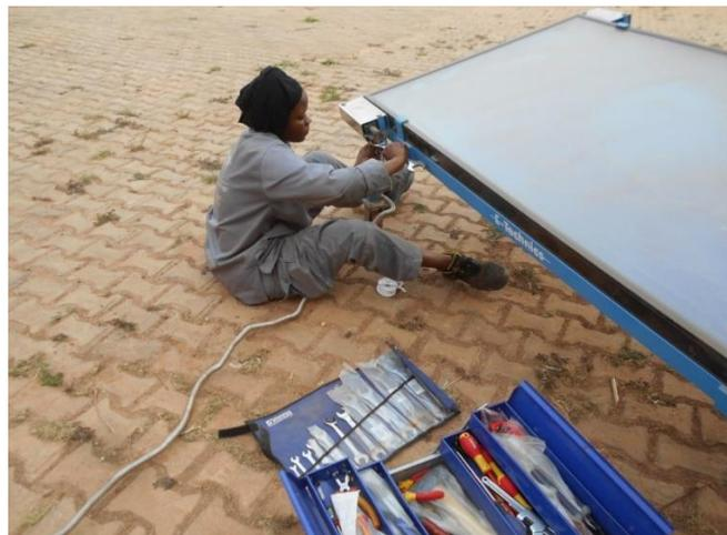
Figure (II.4) : Raccordement des tuyaux (après étanchéité) du circuit solaire.
