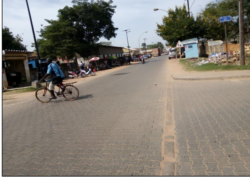
Photo : 1 Route en pavée au quartier Escale-Boudody
