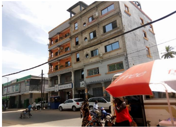
Photo 1: Bâtiment en dur (R+4) au quartier Santhiaba, (Amerdine, 2020)
