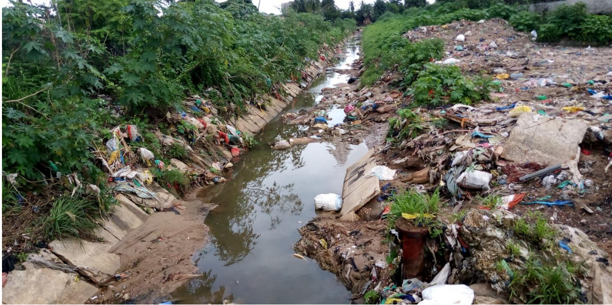
Photo 5. Canal d'évacuation des eaux usées et pluviales (Boudody-Escale, Boucotte et Santhiaba (Amerdine, 2020))
