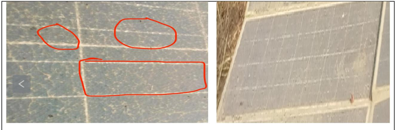
**Figure IV. 9. Décoloration et Souillure observées sur les modules en Casamance**
