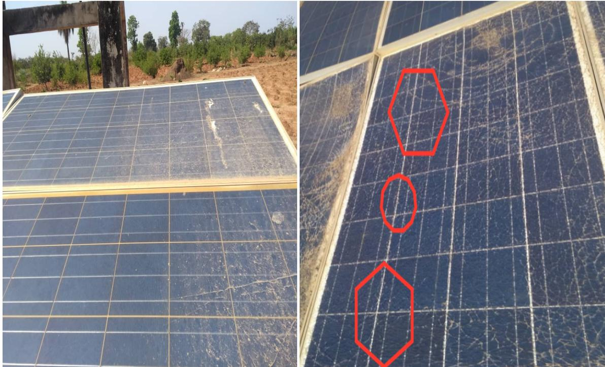
**Figure IV. 7. Système PV installé en Casamance avec des cellules fissurées**
