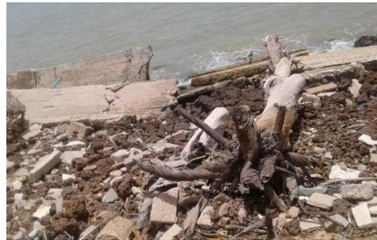
**Photo 8** : Destruction d'arbre et du mur par les houles à Saly
