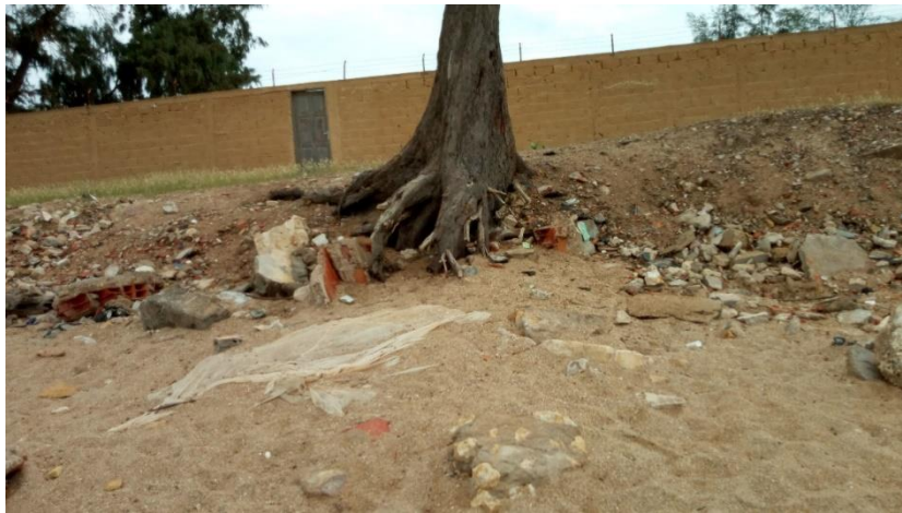
Photo 6 : Le déplacement du mur du centre de réinsertion des jeunes à Nianing Poste
