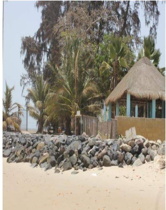
Photo20 : enrochement de protection contre l'érosion à Carabane (Source : MANGA2018)
