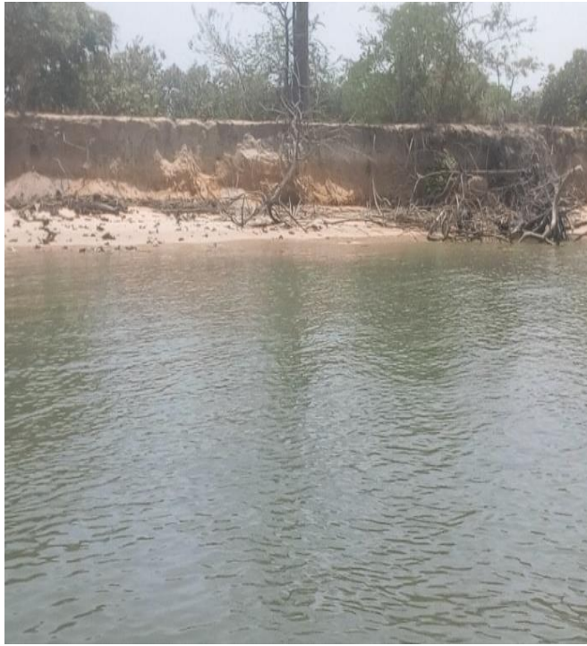
Photo 2 : Erosion à Effrane (source : MANGA 2018)
