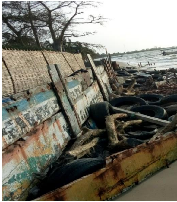
Photo13 : Diguettes de protection contre l'érosion à Carabane (source : MANGA 2018)
