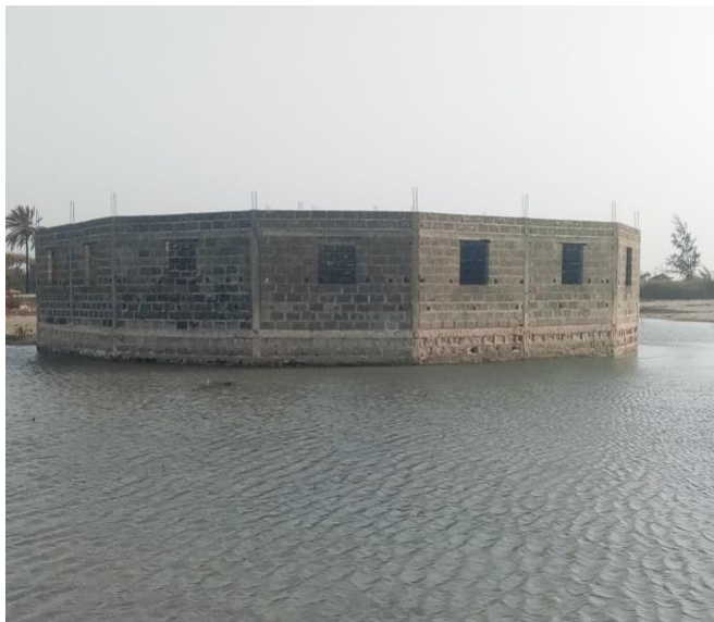
Photo 4 : Envahissement des eaux du fleuve dans une maison durant les hautes marées (source : MANGA 2018)
