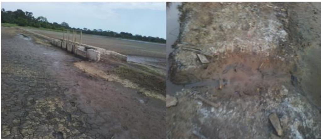
Photo 16: Affaissement d'une digue anti-sel à Niandane, ruptures de la digue anti-sel à Djilacoune, GOMIS, 2017
