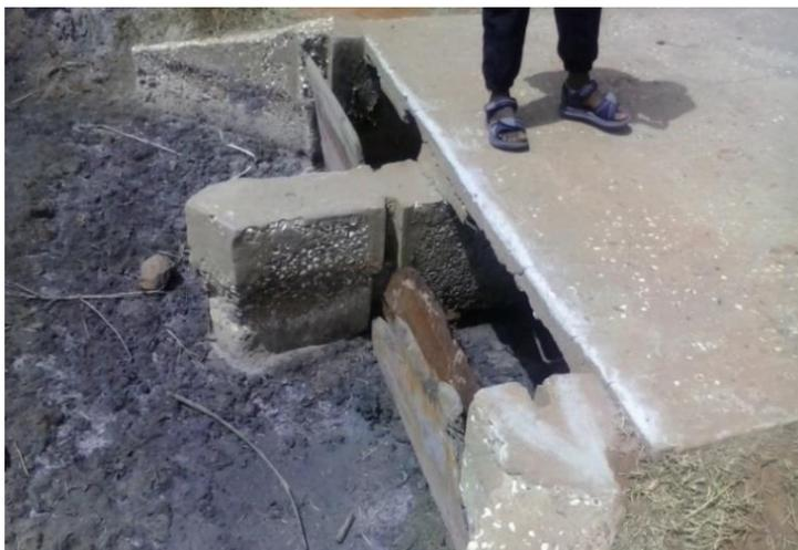
Photo 17: Ouvrage vanné de Coubanao complètement défectueux, GOMIS, 2016
